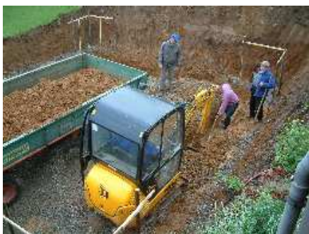
Fundamente werden gegraben ...
