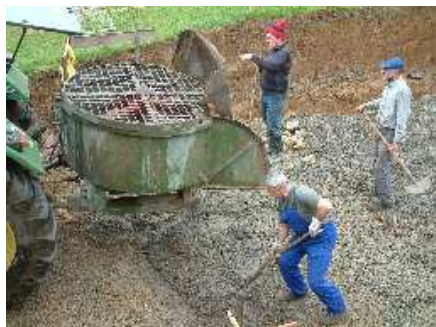
... und gemeinsam betoniert.
