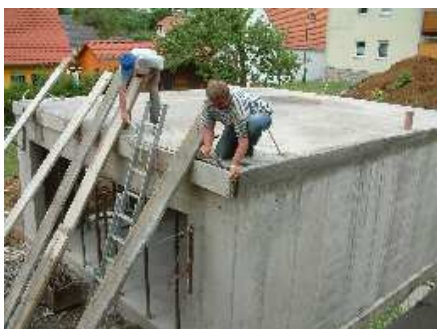
Jetzt steht schon der untere Teil.
